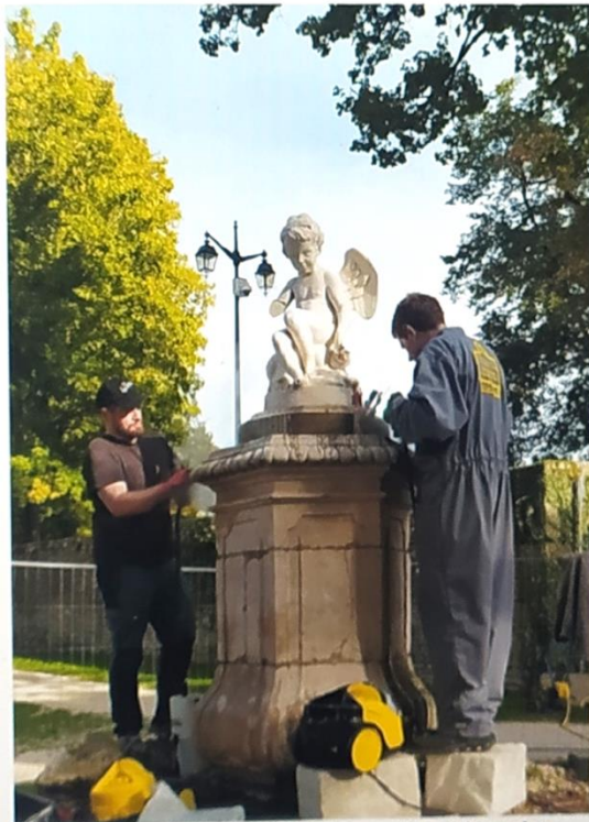
Deux artisans s'occupent de la restauration de l'angelot.
