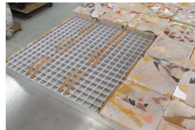
p. Mise en place des bandes de liège.
