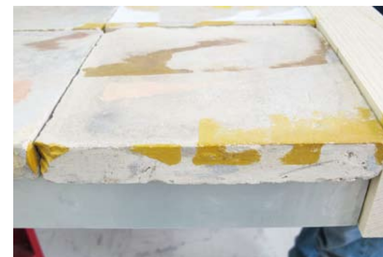
h. La peinture à l'huile appliquée sur les angles cassés et sur le chant dextre des carreaux.
