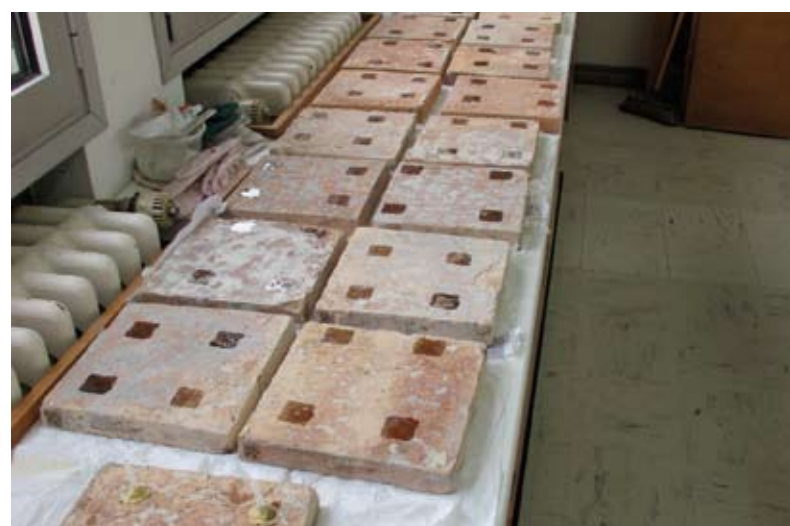
k. Préparation des surfaces poreuses par une première imprégnation de colle epoxy avant la mise en place des plots de fixation des tiges filetées.
